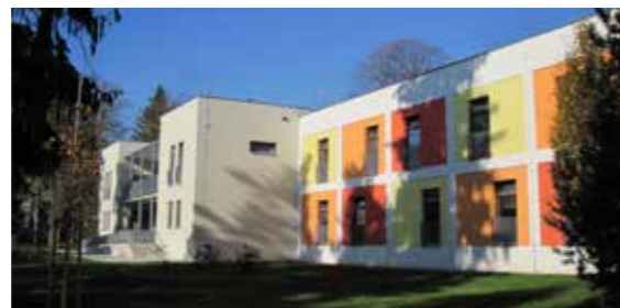
Opravené budovy jsou moderní zvenku i uvnitř a bezbariérové.
